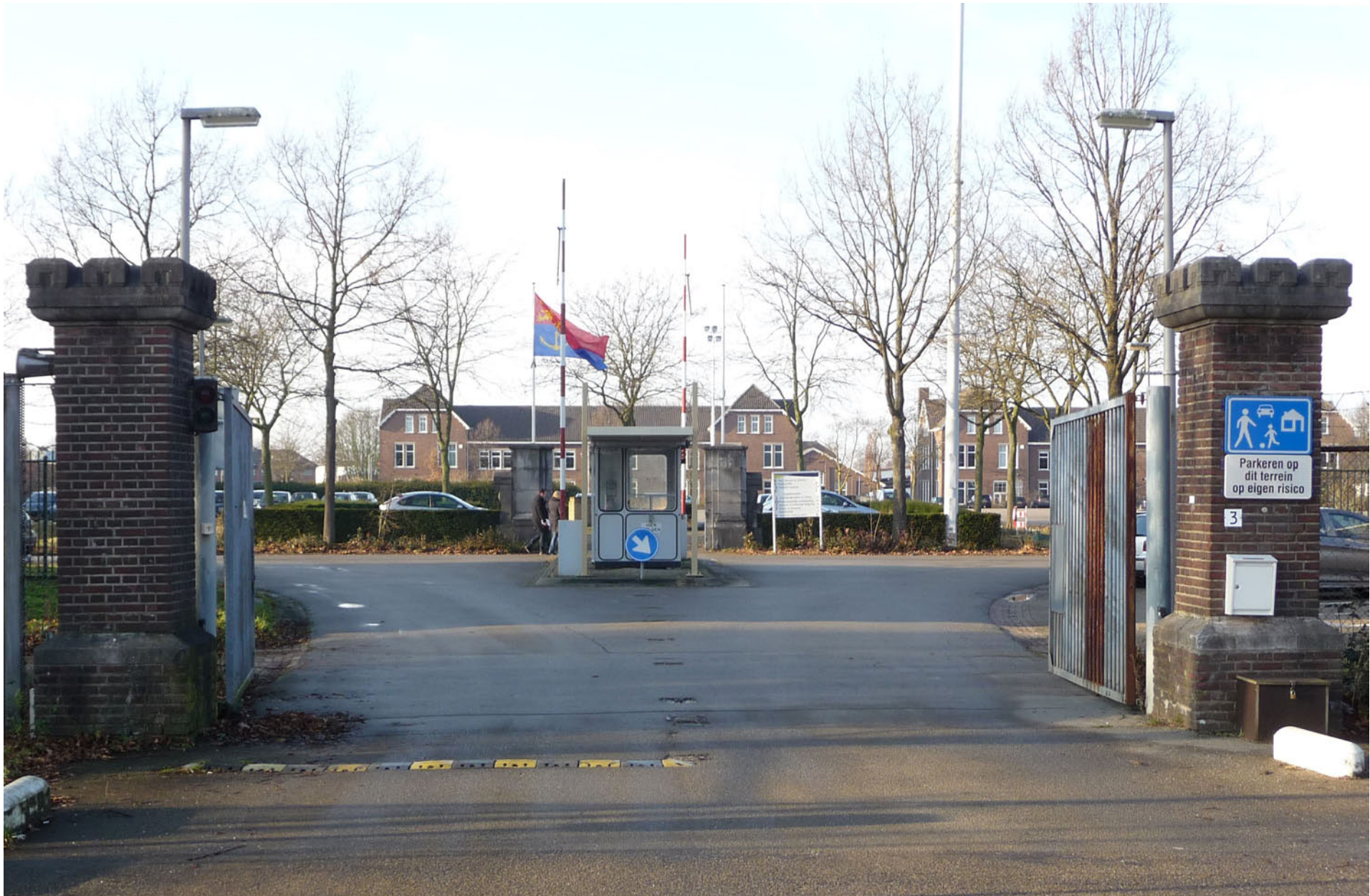
Zicht vanaf de Garnizoenweg tussen de gemetselde poortpijlers van de kazerne en de verplaatste natuurstenen poortpijlers van het fort richting de appèlplaats en legeringsgebouw E.
