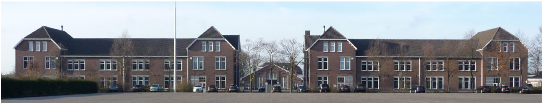
Actueel gevelbeeld van de legeringsgebouwen E en F.
