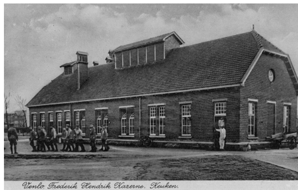
Het gesloopte keukengebouw (bron: internet).
